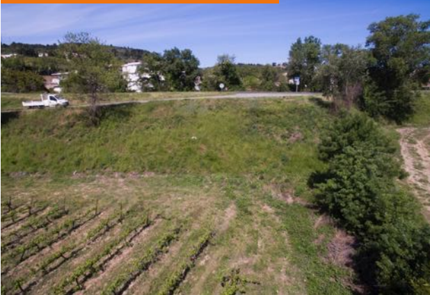
Talus de la bretelle menant à la D609
